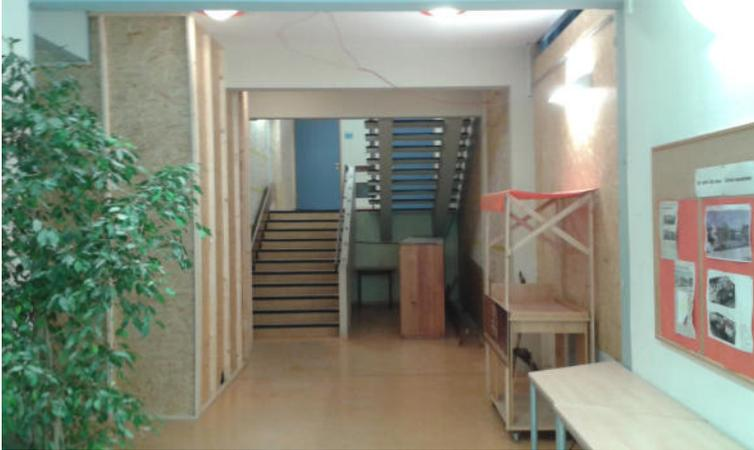
Geländer und Absturzsicherung entsprechen nicht den heutigen gesetzlichen Anforderungen und müssen erneuert werden. Eine Geländermontage wird durch die weit eingerückt Lage der Tragenden Betonbalken erheblich erschwert.
