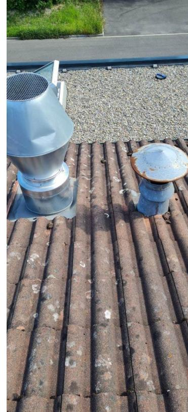
Bestehende Dacheindeckung, Beschichtung (Besandung) fehlt, Platten wurden schon getauscht, zudem weisen die Betondachsteine teilweise Längsrisse auf.
